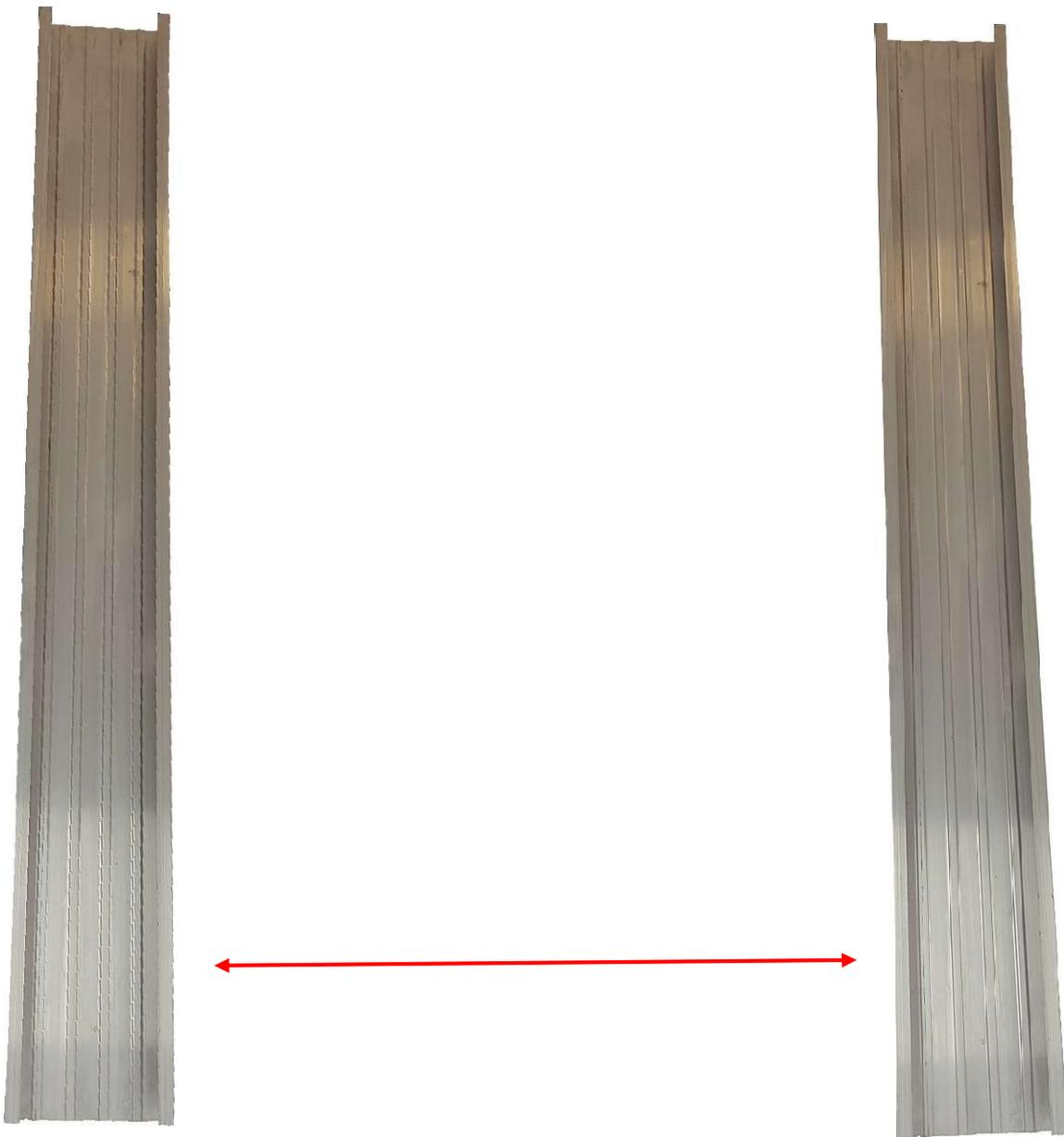
Grundschiene im Abstand der Modullänge ausrichten
